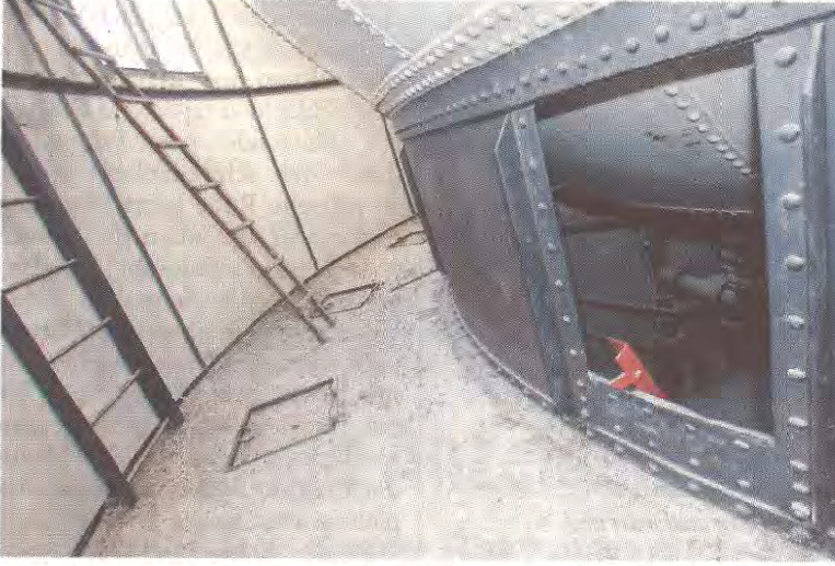
Raffiniert: Der Auflagering holt die Kräfte tangential aus dem Kugelbehälter
